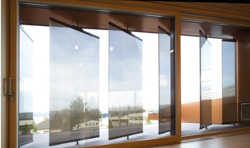
**Abbildung 5:** RHZ / Terrassenbereich. 1150mm breite Lamellen ermöglichen Durchgang.
