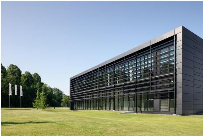
**Bild 5:** Ostfassade des Energy Campus. Der große Glasanteil der P/R-Fassade wird wirkungsvoll durch das außen liegende perforierte Alu-Lamellensystem vor zu großen Strahlungslasten abgeschirmt.
