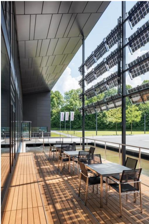
**Bild 3:** Filigrane Halterung der Spezial-PV-Lamellen. Trotz der Spannweite von 5m überzeugt die drehbare Unterkonstruktion mit optischer Leichtigkeit.
