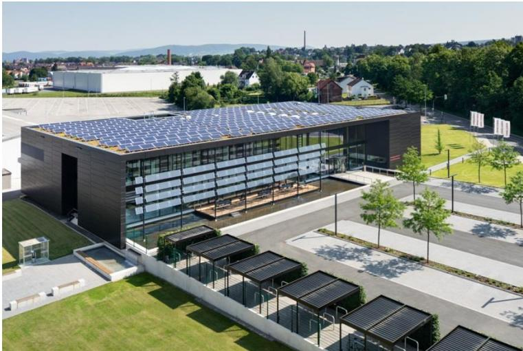
**Bild 4:** Von unten kaum erkennbar. PV-Modul-Flachdachaufständerung, eingebettet in extensive Dachbegrünung, deckt einen großen Teil des elektrischen Energieverbrauchs.
