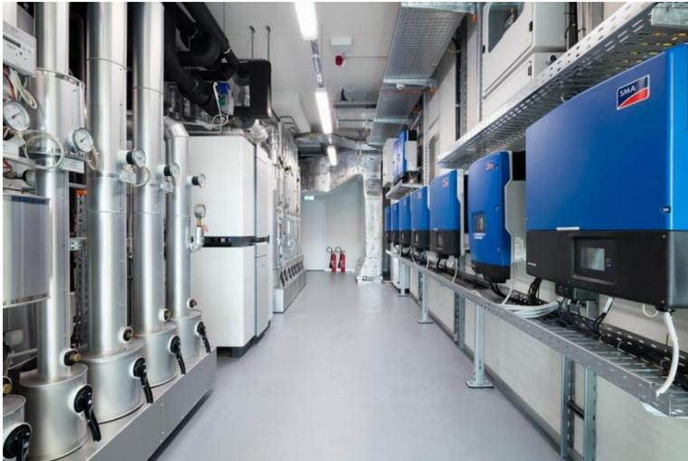
**Bild 10:** Der Technikraum, ein Sahnestück für sich, der auch für Schulungszwecke genutzt wird. Die blaue Kaskade an Wechselrichtern formt den PV-Anlagen-Gleichstrom in netzkonformen Wechselstrom um.
