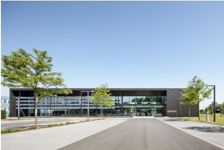
**Bild 2:** Ansicht der Südfassade des Energy Campus. Die angewinkelten PV-Lamellen sind zur Sonne ausgerichtet, verbessern damit Sonnenschutz und Energieerzeugung.
